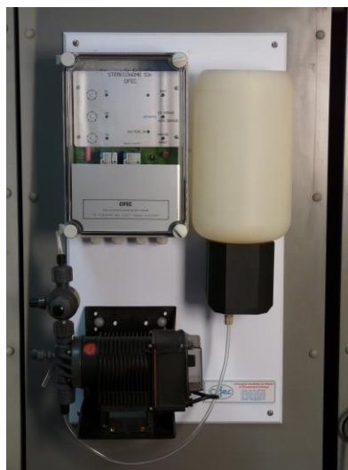
Stéréconome Javel prémonté sur panneau mural 700*500mm avec coffret, pompe et bac de 4L
